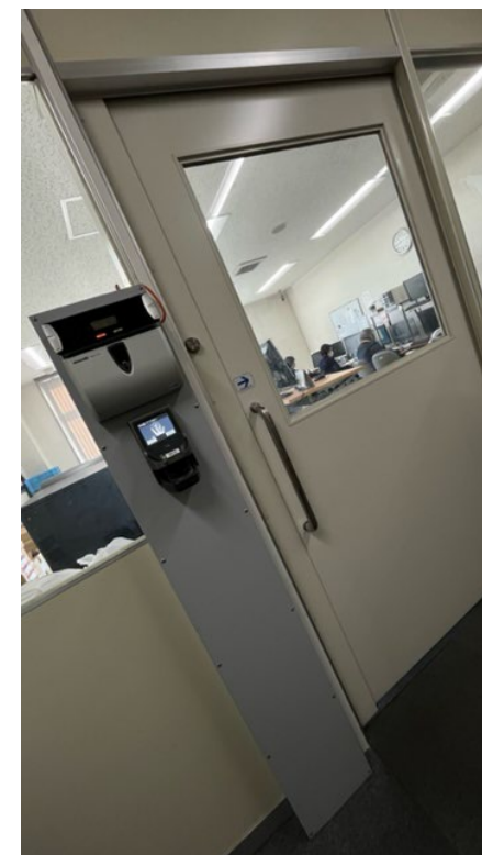
静脈認証 で制御された扉
